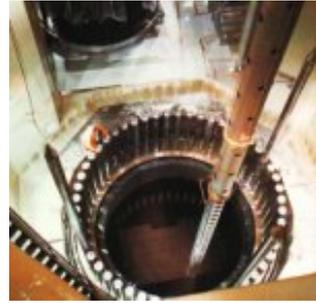
El combustible nuclear se encuentra en el interior de una vasija herméticamente cerrada. El calor generado en el combustible del reactor y transmitido después a un refrigerante se emplea para producir vapor de agua, que va hacia la turbina, transformándose su energía en energía eléctrica en el alternador.
